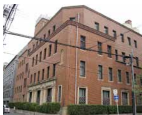
建物全景(修景前)
